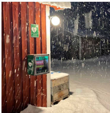
Vid placering utomhus ska skåpet vara larmat och tåla vinterklimat
